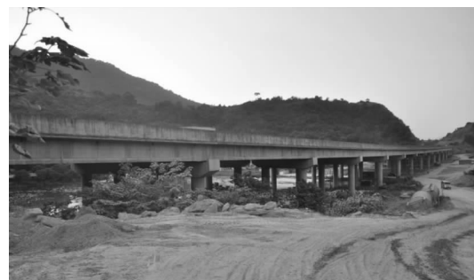
图 1 苏洋大桥照片
